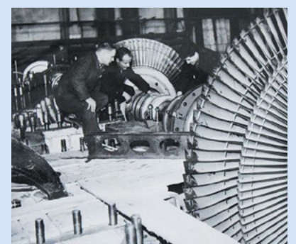
Монтаж первой турбины Т-100–130, 1962 год
