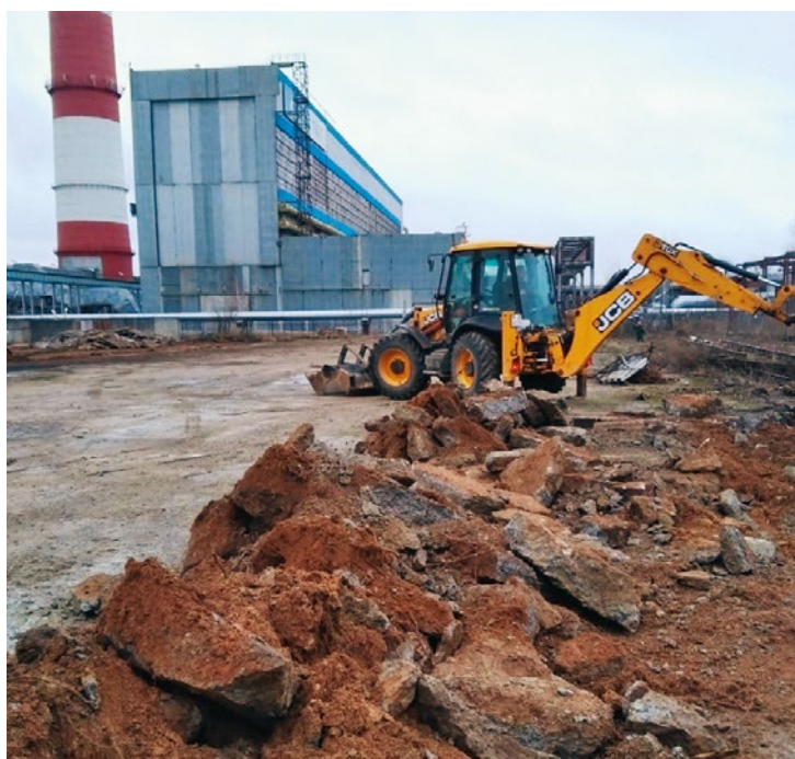
Площадка строительства ЕЛЦ, январь 2020 года
