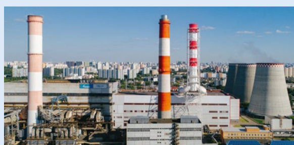
Проект модернизации ТГ-7 ТЭЦ-21 предполагает замену цилиндра высокого давления паровой турбины, барабана и топочных экранов котлоагрегата
