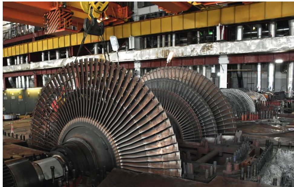
☐ Капитальный ремонт энергоблока № 4 ТЭЦ-25, 2019 год. В 2020 году на этой электростанции и ТЭЦ-22 также планируются капремонты турбин Т-250 с заменой рабочих лопаток роторов низкого давления
