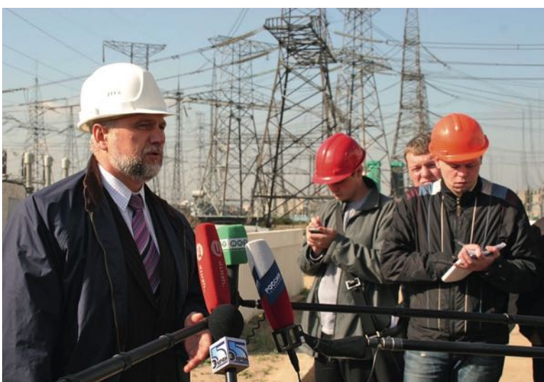
На площадке строительства энергоблока ПГУ-420 ТЭЦ-26, 2008 год
