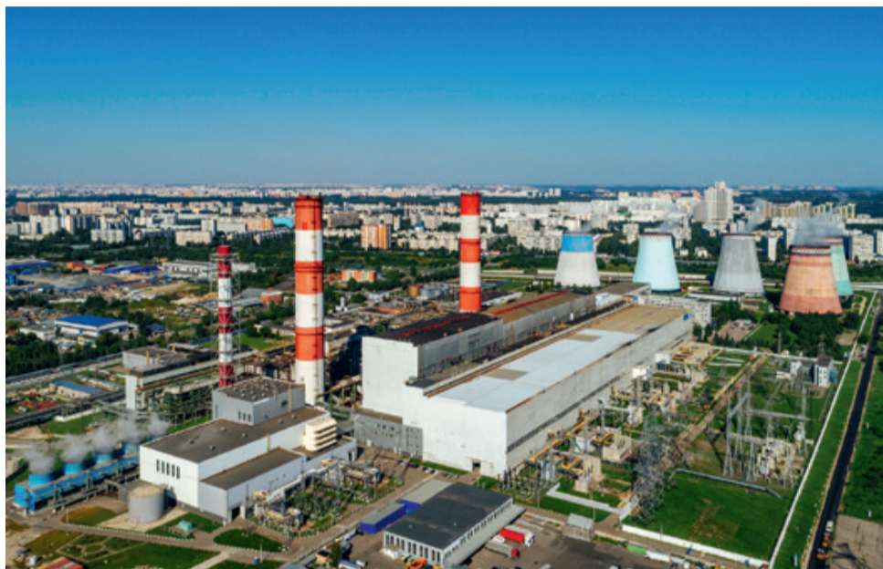
ТЭЦ-26 – крупнейшая электростанция Мосэнерго по показателю установленной электрической мощности. Она обеспечивает централизованное теплоснабжение районов юга и юго-востока столицы с населением более 2 млн человек
