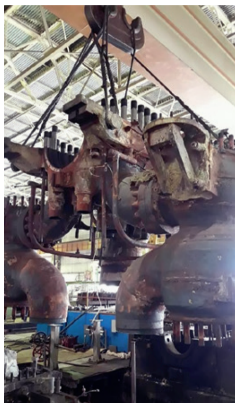
Демонтаж нижней половины цилиндра среднего давления №1 (ЦСД-1) турбины №5 ТЭЦ-26. После среза цилиндра была выполнена замена металлофторопластовой ленты корпуса подшипниковых опор турбины
