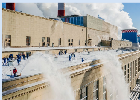
Очистка кровли главного корпуса ТЭЦ-16
