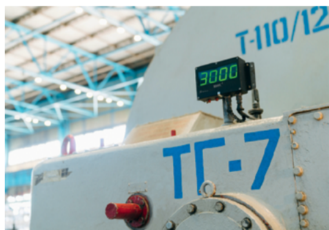
На ТГ-7 ТЭЦ-8 запланирован ремонт проточной части турбины с заменой рабочих лопаток, а также работы по нормализации тепловых расширений с установкой МФЛ
