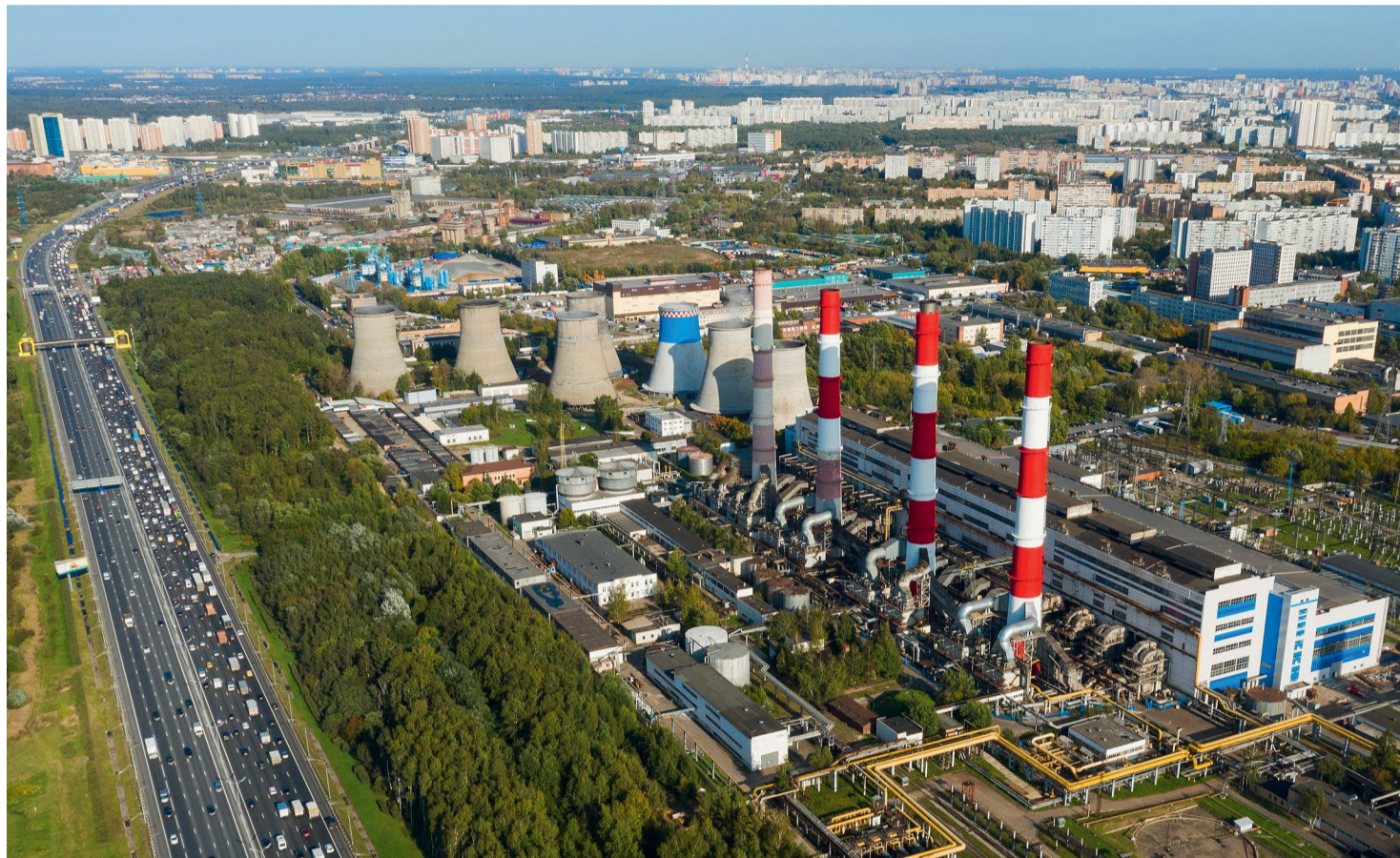
На ТЭЦ-21 в ходе ремонтной кампании 2022 года планируется замена фронтального и боковых экранов ПВК-7 и замена конвективной части ПВК-10
