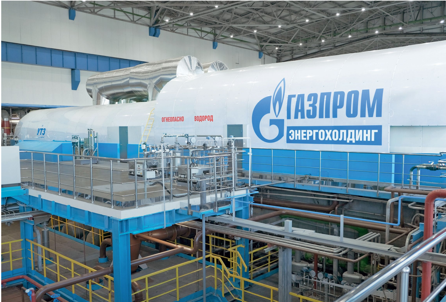
Электрическая мощность Т-295 при работе в конденсационном режиме может достигать 335 МВт
