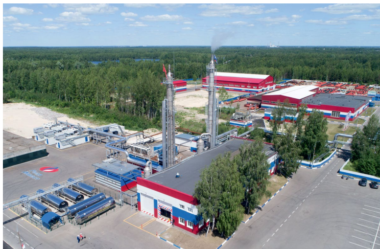
Завод по утилизации дымовых газов и производства двуокиси углерода расположен в Балахнинском районе Нижегородской области
