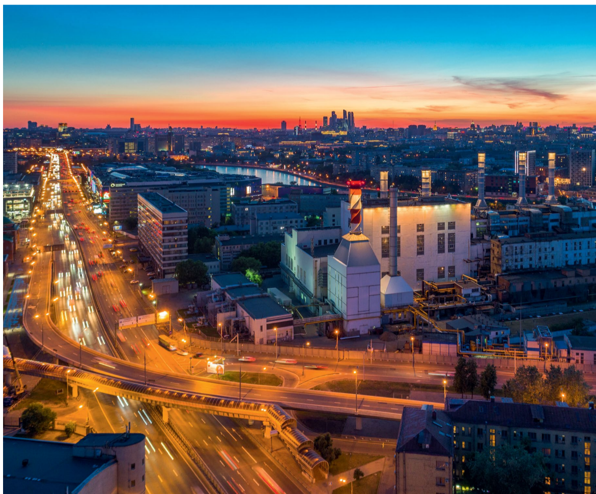
На ТЭЦ-9 в рамках инспекции блока ГТЭ-65 завершен ремонт генератора ТГ-1
