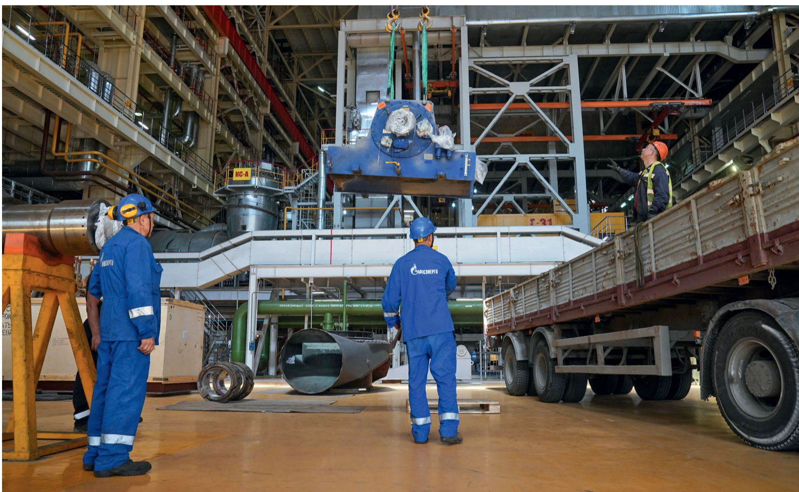
Перемещение гидромолоты питательного насоса энергоблока № 4 ТЭЦ-27, июль 2022 года
