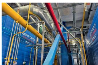
В рамках техпереворужения на станции установлены три котла производства ООО «Дорогобужкотломаш»
