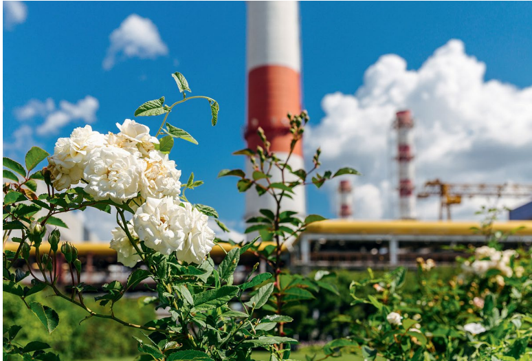
ТЭЦ-27 нередко называют самой экологически чистой тепловой электростанцией Европы
