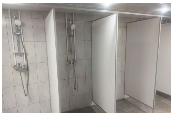
Отремонтированная душевая в главном корпусе ТЭЦ-22, май 2023 года
