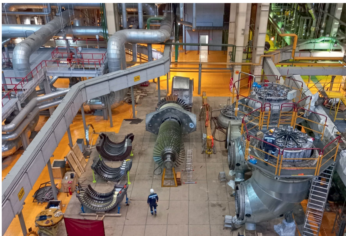
Главная инспекция газовой турбины ГТ-42 энергоблока № 4 ПГУ-450 ТЭЦ-27, апрель 2023 года
