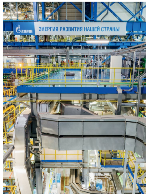
На блоке ПГУ-220 ТЭЦ-12 выполнена главная инспекция газовой турбины ГТ-1А
