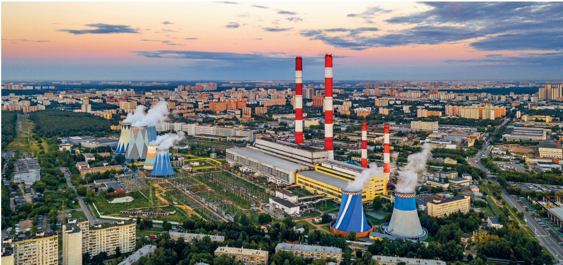
На ТЭЦ-23 выполняется техперевооружение пяти водогрейных котлов ПТВМ-180 с заменой поверхностей нагрева
