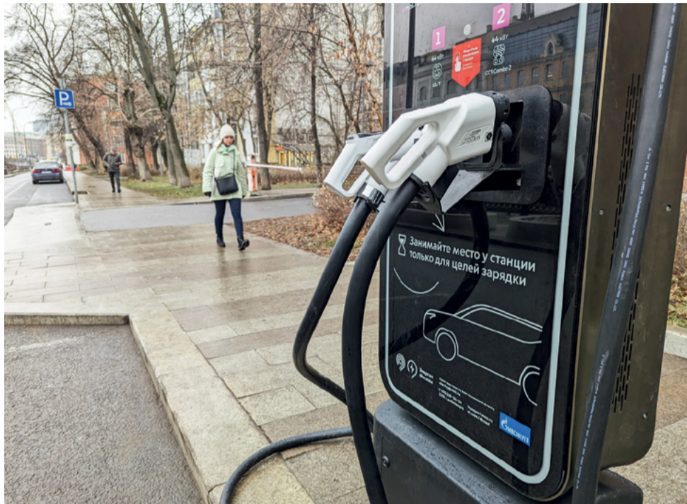
Модернизированные ЭЭС оснащены разъемами двух типов, позволяющими заряжать самые популярные модели электромобилей
